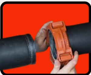
Ajuste la tuerca al par de apriete recomendado, consulte la página 16 101T. Inspeccione visualmente el acoplamiento para asegurarse de que las chavetas de la carcasa estén acopladas en las ranuras de la tubería.
